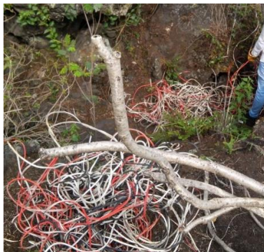
Fig. 46. Residuos del robo de cable.
