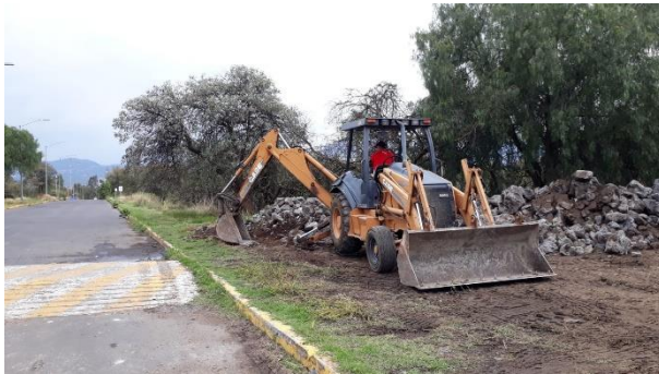
Fig. 60. RetrosCADadora empleada en los trabajos de la zona
